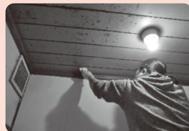
浴室の天井のカビ取りをしている様子
